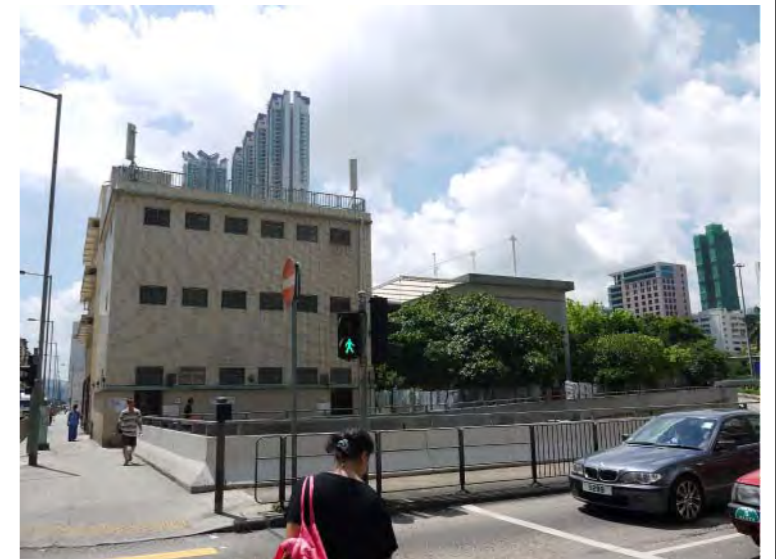
4 啟德隧道出入口附近的行人路被行車路分隔
